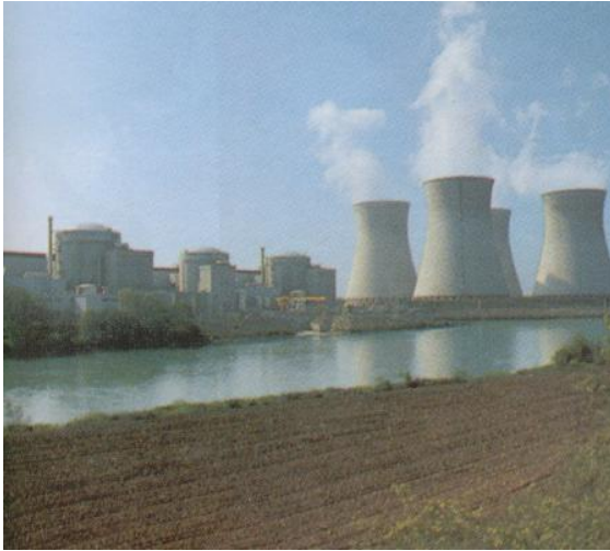
Un esempio di centrale nucleare
