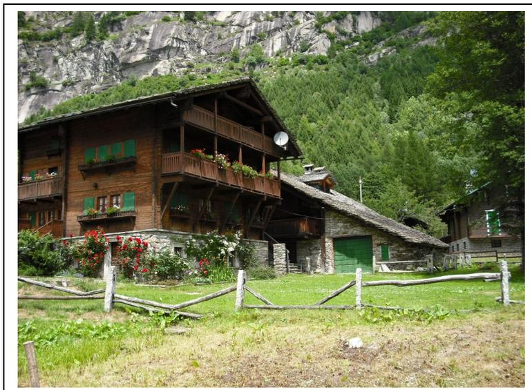
Il peso della copertura in pietra cui si aggiunge, per molti mesi il peso della neve, impone travature di notevole robustezza, ma offre anche il vantaggio di ben assestare le giunzioni tra le travi di legno, aumentando la solidità del complesso.
