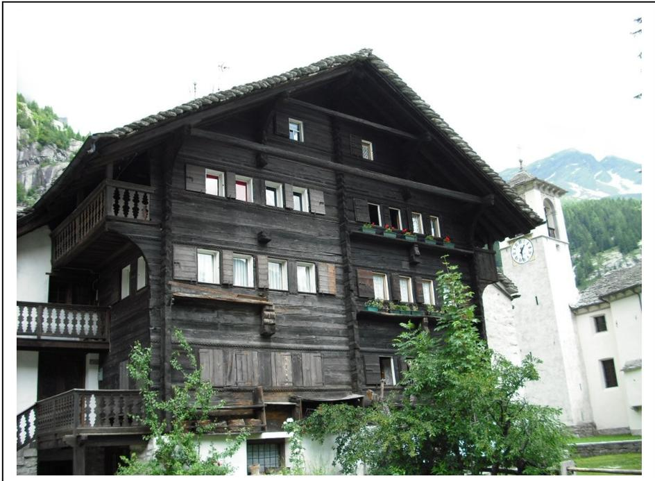
La solidità e resistenza nel tempo è data dall'incastro angolare delle travi, detto a “**block-bau**”, resistente agli agenti atmosferici e che mantiene in asse la struttura.
